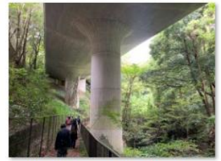
09 陣ヶ下溪谷（高架道路橋脚）.JPG
